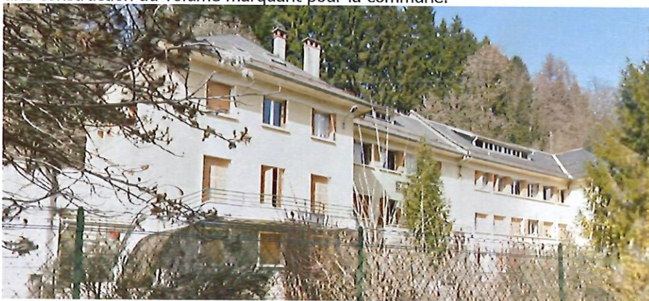
Vue côté sud ouest
