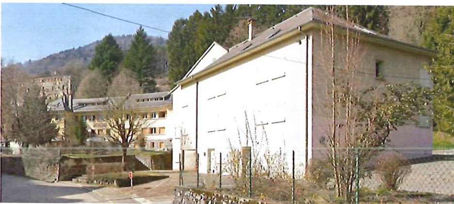
Vue côté nord est
